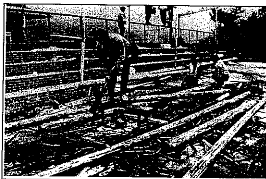
圖 12 示範工程新建看台屋架組構施工情形
